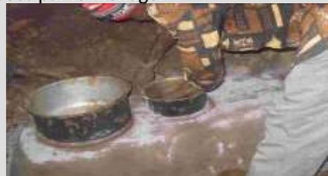
Les foyers sont ensuite creusés, sur le dessus et par le côté où sera enfourné le bois. Quelques trous d'aération sont aussi percés de façon à faciliter la combustion. Enfin, le tout est lissé pour obtenir une bonne finition.
